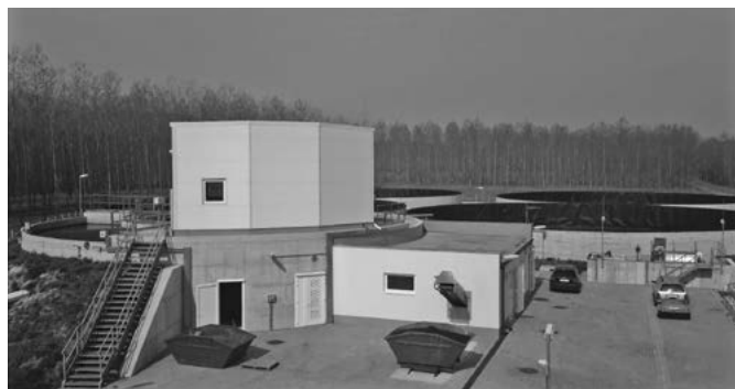
Korszerű szennyvíztelep építése KEHOP
